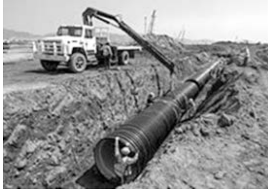
Рис.62. Встановлення гофрованої труби із ПВЩ для дренажного проекту
